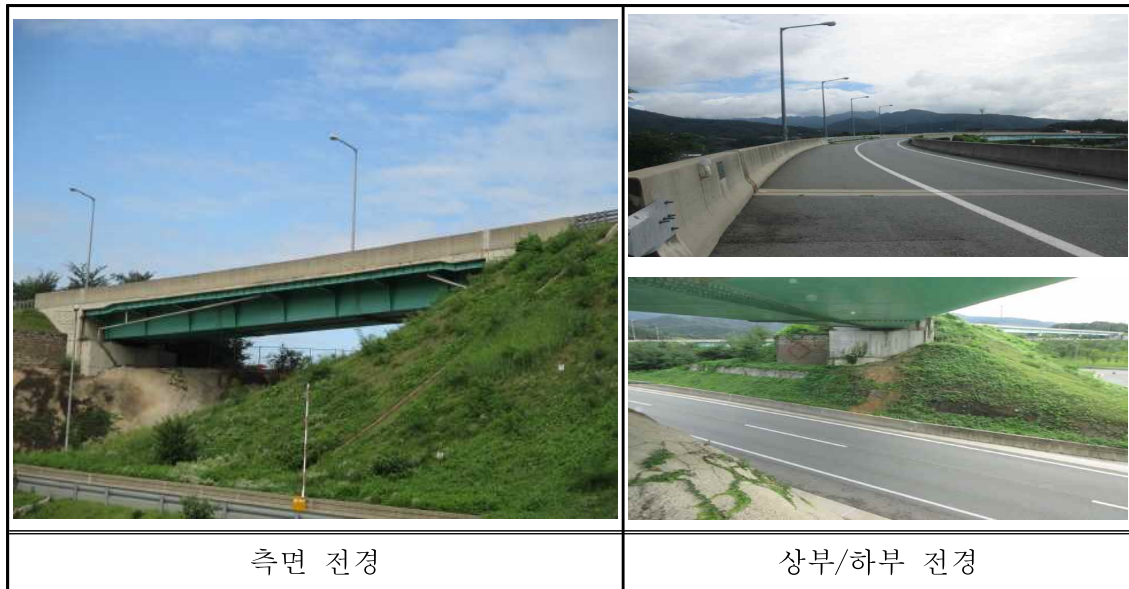
<그림 1.3.1> 동대구 JCT 1교 전경
