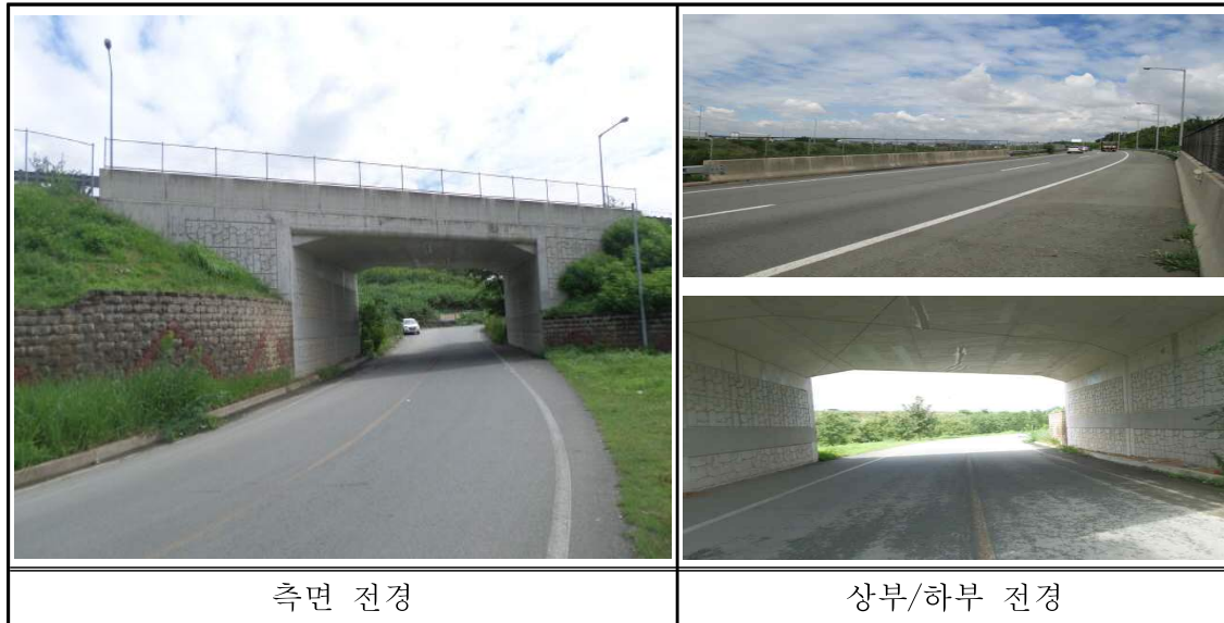
<그림 1.3.5> 동대구 JCT 4교 전경
