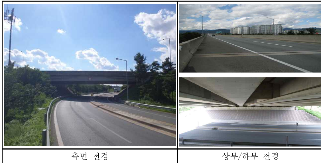
<그림 1.3.9> 동대구 IC교 전경
