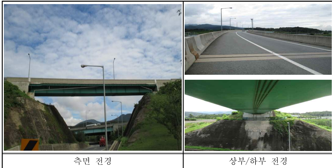
<그림 1.3.3> 동대구 JCT 2교 전경
